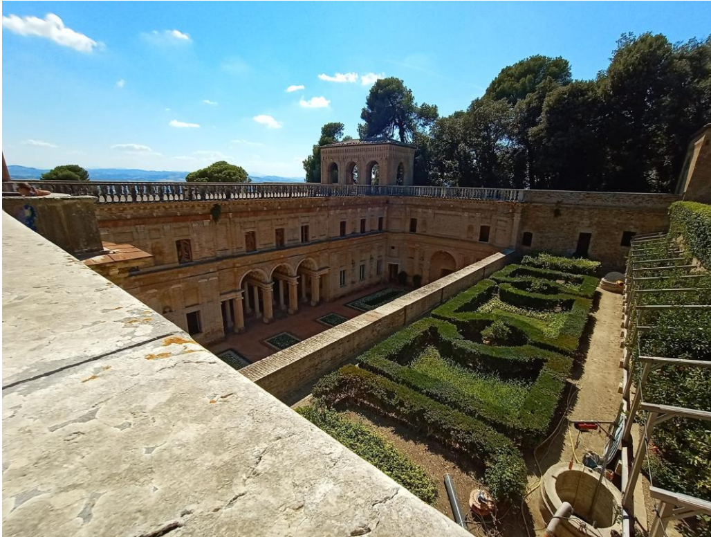
Рис.6. Вилла делла Ровере. Вид на жилой корпус, утопленный двор и висячий сад. Фото: Татьяна Нешумова
